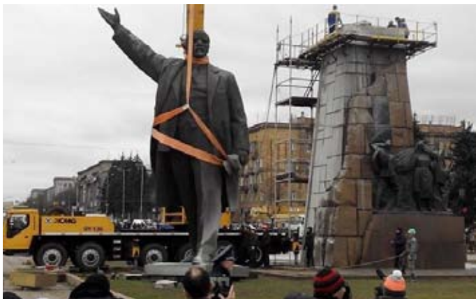
Демонтаж пам'ятника Леніну в Запоріжжі
