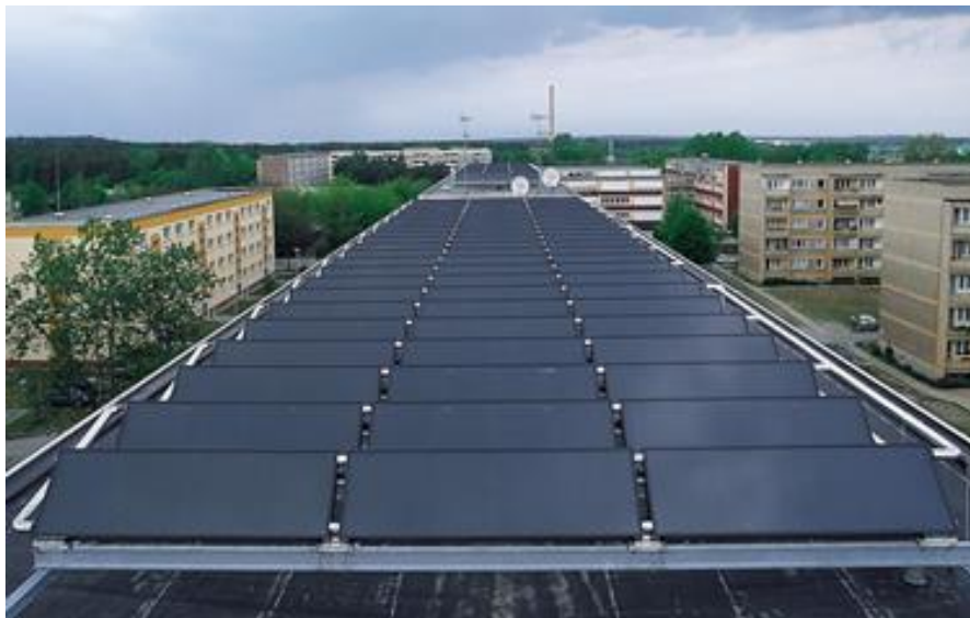
Рисунок 2.1 – Поле геліоколекторів на плоскому даху
