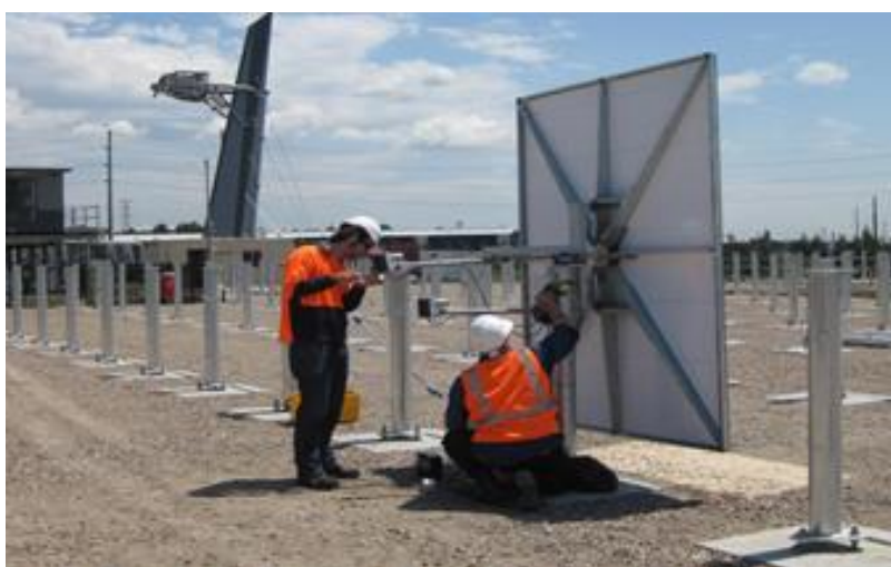
Рисунок 3.9 – Обслуговування редуктора трекера
