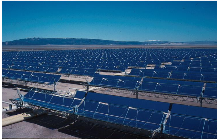
Рисунок 3.3 – СЕС із роздільними модульними параболічними концентраторами
