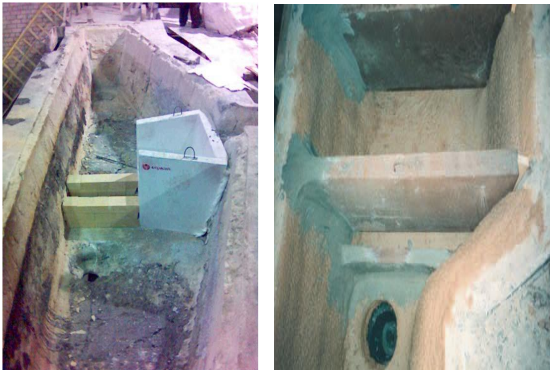
Рисунок 3.21 – Установлення металоприймача й перегородок у промковші
