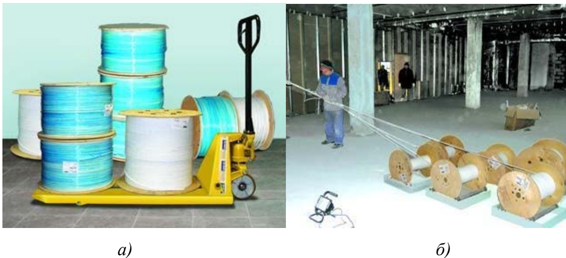
Рисунок 14.20 – Котушки з кабелем PiMF600 (а) та його розмотування і укладання в лотки (б)
