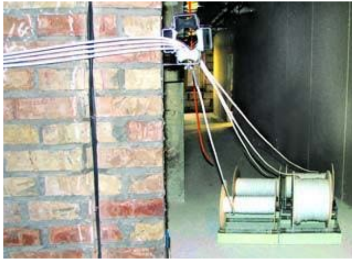
Рисунок 14.21 – Розмотування кабелю і обхід повороту
