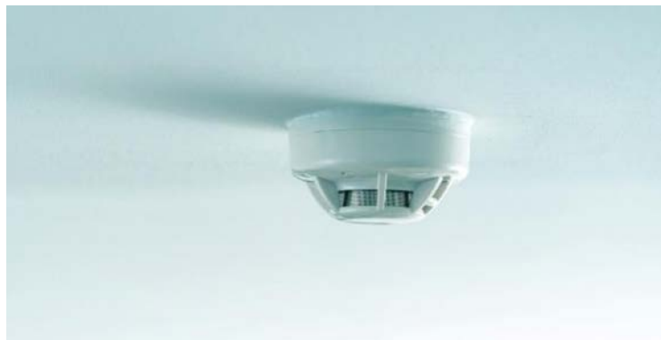
Рисунок 5.12 – Установка пожежного сповіщувача на стелі [13]
