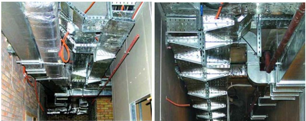
Рисунок 14.19 – Багаторівнева єдина система кабельних трас
