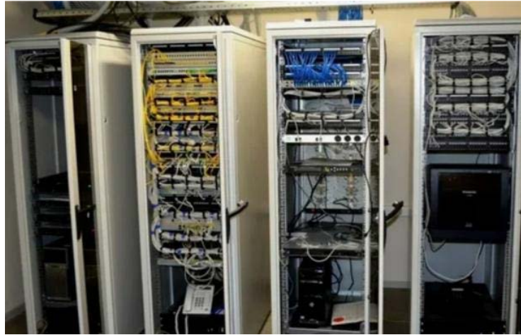
Рисунок 14.4 – Обладнання апаратної СКС [6]
