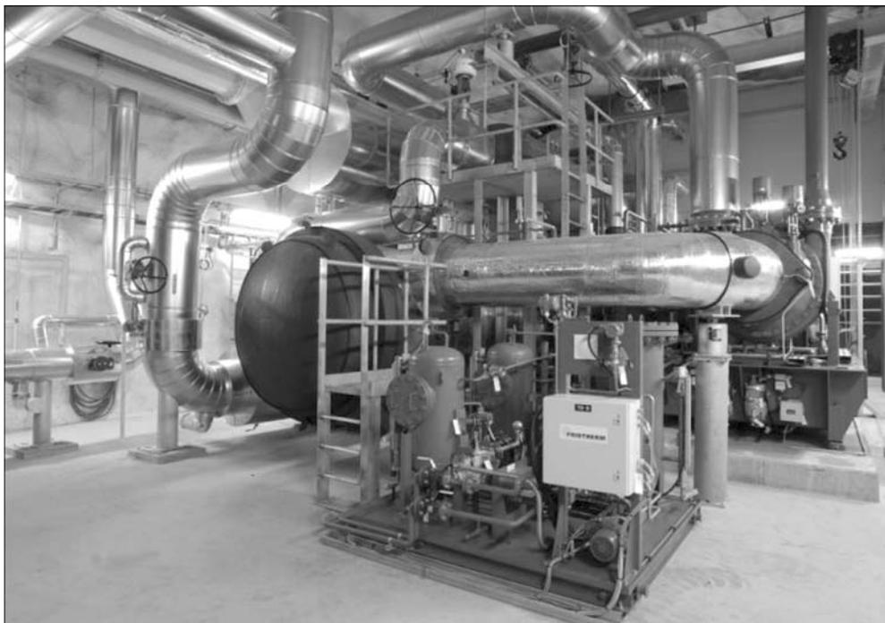
Рис. 5.8.4. Високотемпературний тепловий насос типу Unitop® 50 FY «Friotherm AG». Джерело: <https://www.friotherm.com/products/unitop/unitop-50/>
