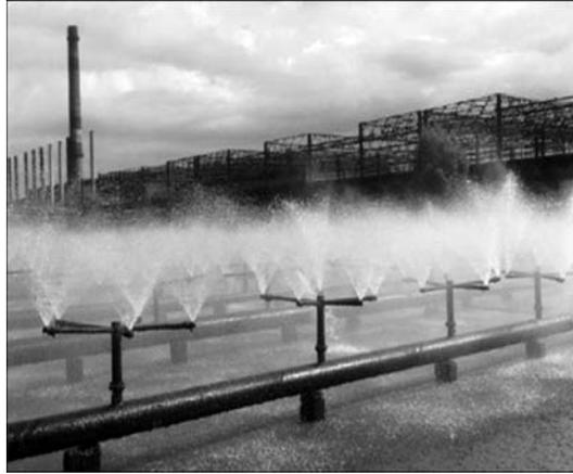
Рис. 5.7.1. Бризкальний басейн-охолодник
