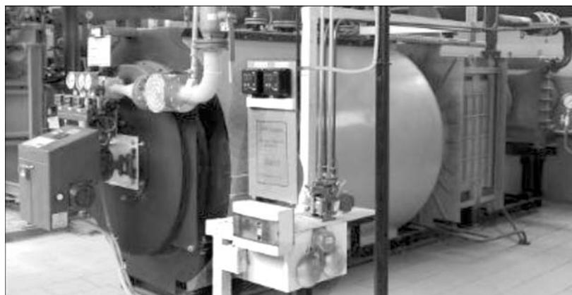
Рис. 5.3.7. Жаротрубний котел КВМУ-1,25 Гн розробки ІТТФ НАНУ
