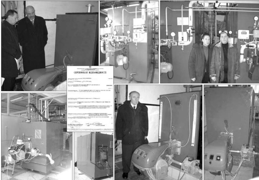
Рис. 5.3.6. Водогрійні котли КВВ-1,0 Гн, КВВ-2,0 Гн, КВВД-0,63 Гн розробки ІТТФ НАНУ
