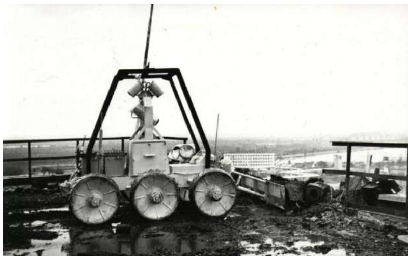
Рисунок 2.19 – Робот на даху Чорнобильської АЕС, під час ліквідації наслідків аварії, 1986 рік
