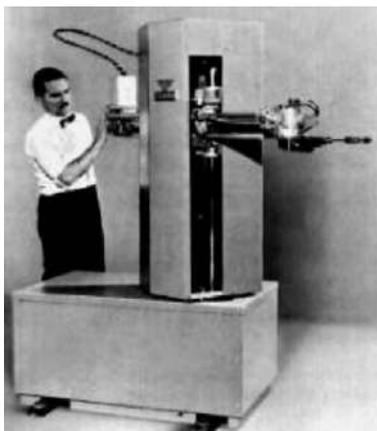
Рисунок 2.16 – Робот Versatran
