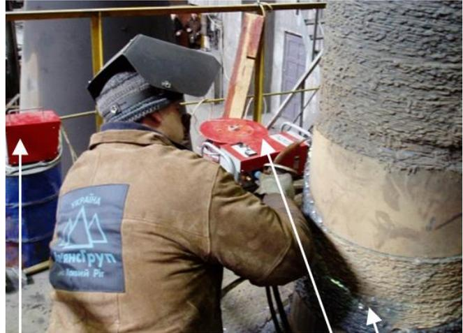
**Рис. 3.31. Наплавлення вала напівавтоматом ПШ107В:**
