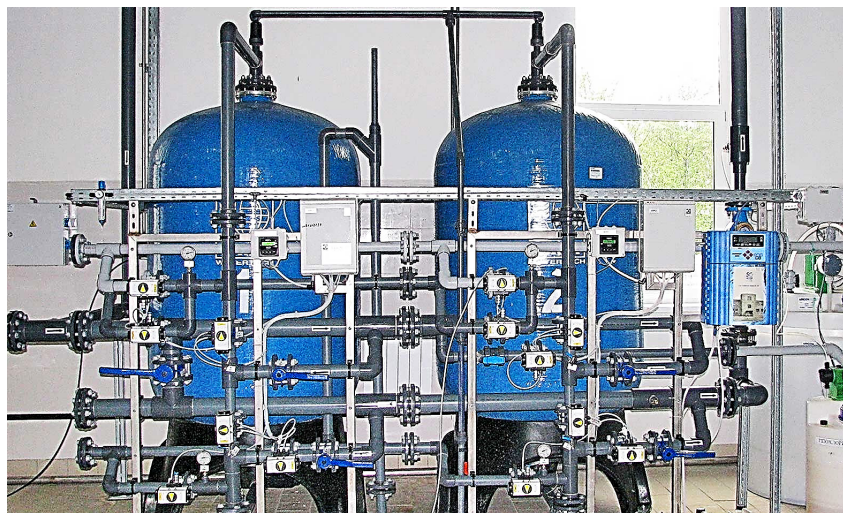
Рисунок 11.6 – Система двоступеневої рекарбонізації оборотної води
