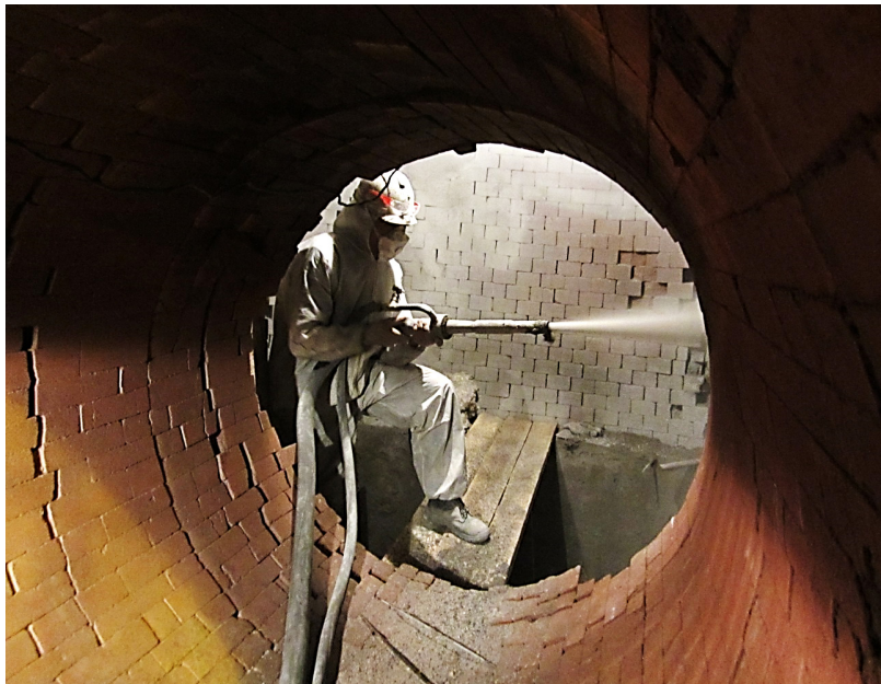
Рисунок 9.5 – Нанесення торкрет покриття на стіну з цегли
