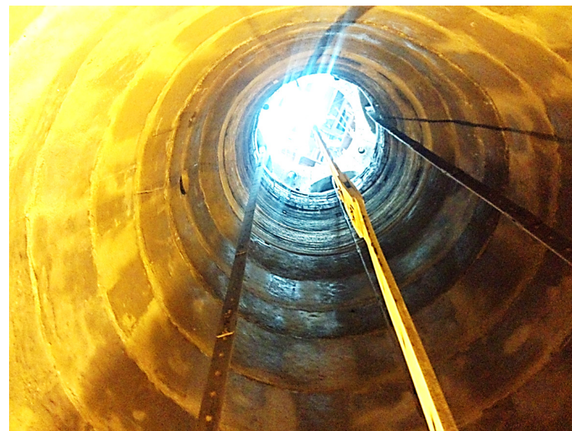
Рисунок 9.4 – Футеровка шахти доменної печі
