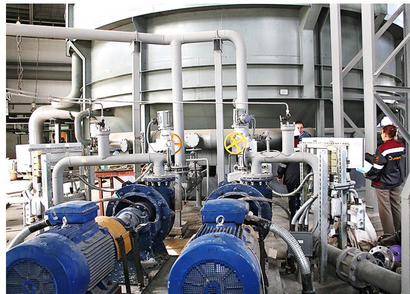
Рисунок 11.5 – Комплекс оборотного циклу водопостачання газоочищення доменного цеху
