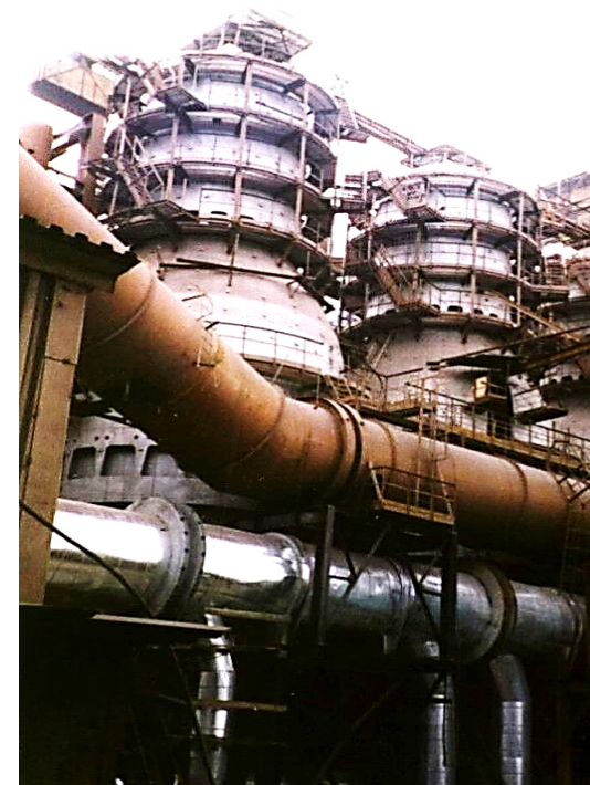
Рисунок 5.2 – Повітрянагрівач для нагріву повітря (холодного дуття, що надходить із повітрорудної машини) перед подачею його в доменну піч
