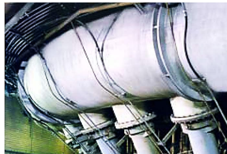
Рисунок 5.5 – Кільцевий повітропровід доменної печі
