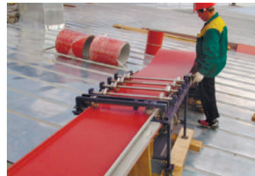
Рис. 6.12. Механізоване виготовлення фальцевих швів
