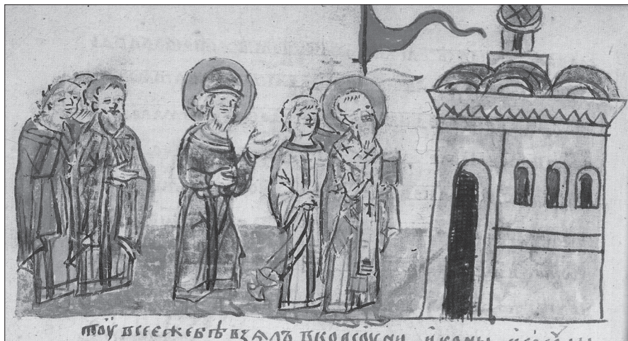
Будівництво Володимиром Десятинної церкви в Києві.
