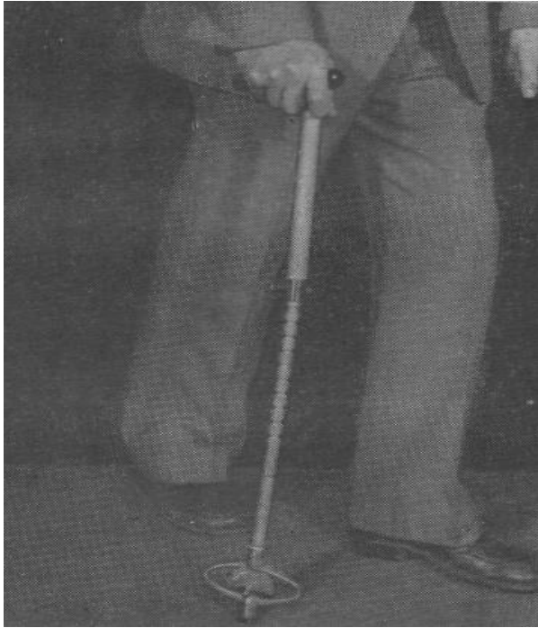
Рис. 19. Визначення навантаження на ногу з динамометром, вмонтованим у палицю
