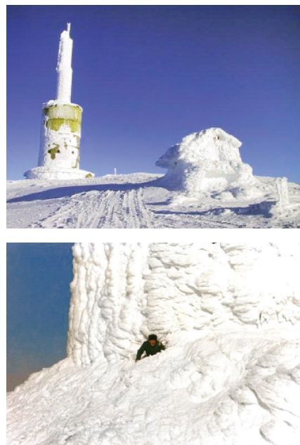
Рис. 5.27 Телестанція взимку в Норвегії. Вгорі зображена вкрита льодом антена; внизу — обмежений вхід
