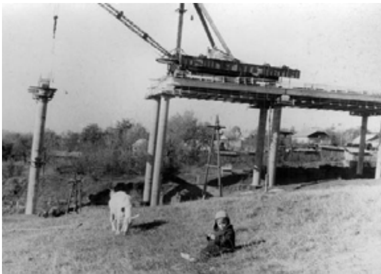
Іл.3-4. Початок будівництва мосту
