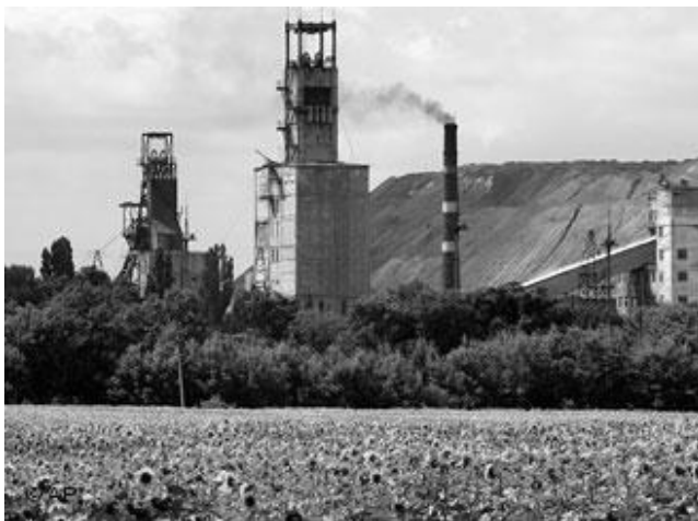
Рисунок 2.1 – Наземні шахтні споруди
