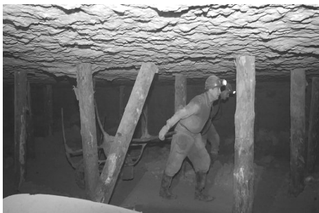
Рисунок 2.5 – Підготовка до кріплення виробки
