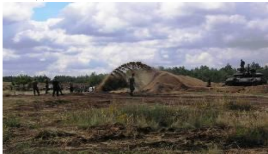
Рис. 2.45. Обладнання земляного валу периметру базового табору з допомогою МДК-3
