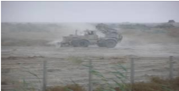
Рис. 2.40. Розчистка ділянки під елемент базового табору
