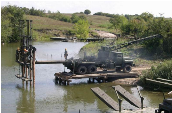
Рис.9.17. Загальний вигляд УСМ-2
