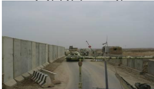
Рис. 2.49. Встановлення конструкцій для ведення вогню вздовж лінії проходження техніки
