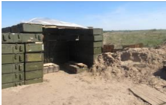
Рис. 2.47. Вогнева позиція з ящиків з піском базовий табір 239 ЗВП “Новомосковський”
