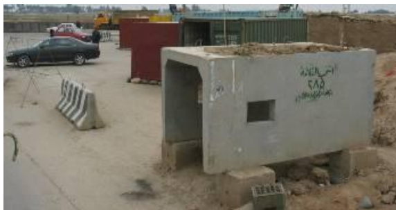
Рис. 2.50. Обладнання вогневої точки
