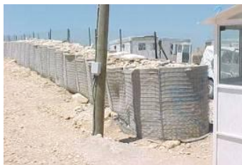
Рис. 2.44. Варіанти встановлення захисних валів (Ірак).
