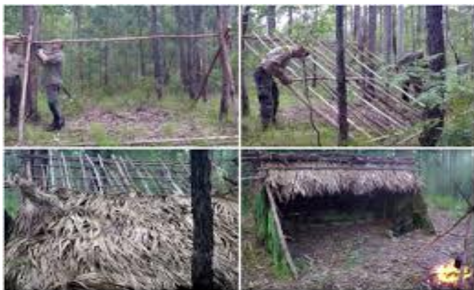
Рис. 6.10. Спорудження односхилого куреня
