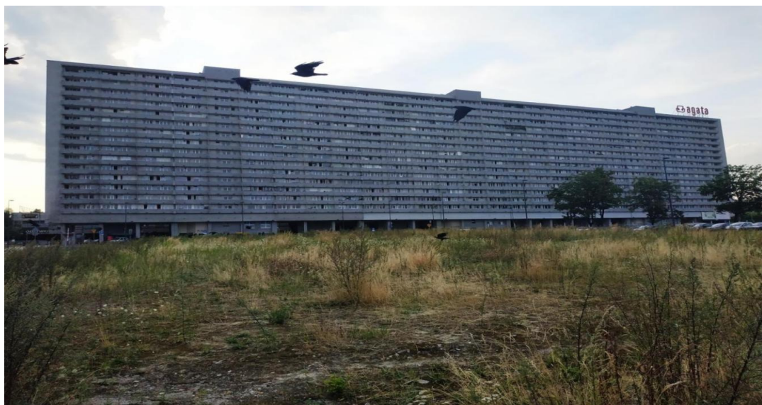
Рисунок 7 Багатоповерхова будівля, місто Катовіце (Польща)
