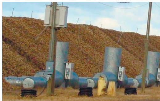
Рис. 131. Установки для активного вентилявання кагатів цукрових буряків
