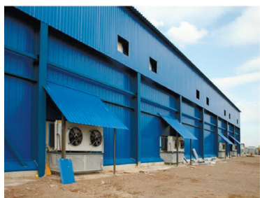
Рис. 168. Зберігання цибулі насипом у стаціонарному цибулесховищі з активним вентиляванням
