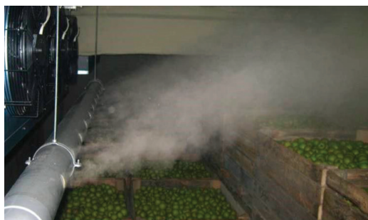
Рис. 115. Регулювання вологості в овочесховищах за допомогою туманоутворювальної системи
