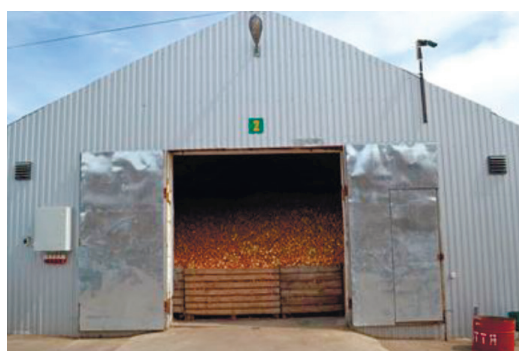
Рис. 134. Провітрювання сховищ без активної вентиляції
