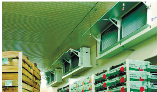
Рис. 133. Інтенсивне вентилявання підігрітим повітрям під час перепаду температур у сховищі
