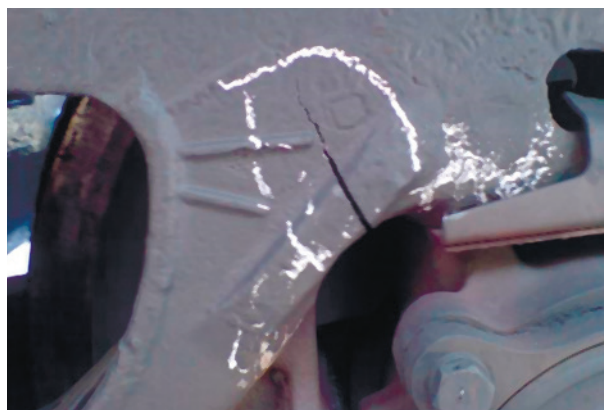
Рис. 1.9. Утворення тріщин на деталях
