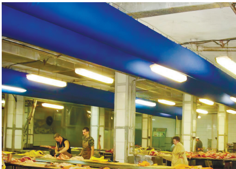
Рис. 1.16. Текстильні повітропроводи для зменшення швидкості повітря до нормованих значень у робочій зоні
