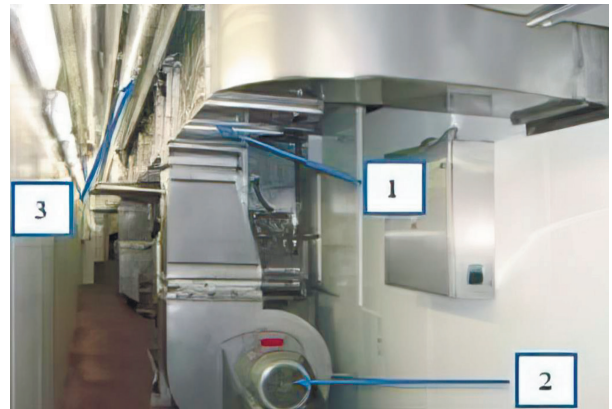
Рис. 2.16. Камера охолодження м'яса з міжшляховими повітроохолоджувачами з гладких труб:
