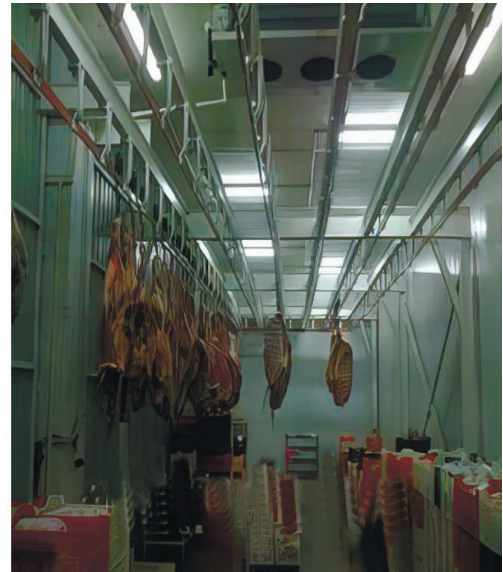
Рис. 2.8. Камера охолодження м'яса з мокрими повітроохолоджувачами:
