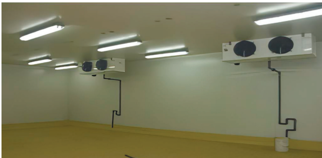
Рис. 5.31. Камера з РГС «Сандвіч»-панелей
