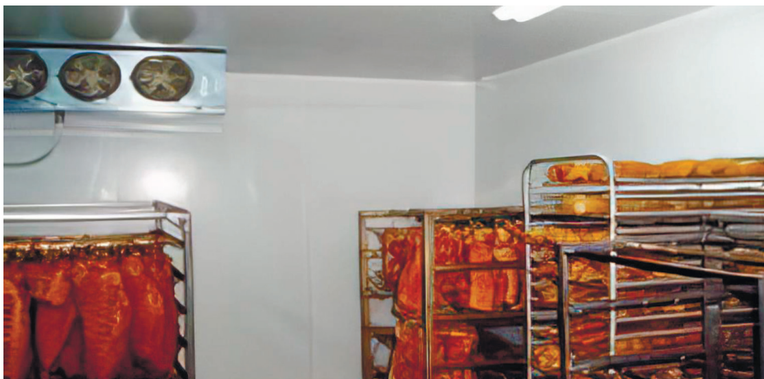
Рис. 2.22. Камера охолодження м'яса з підвісними повітроохолоджувачами
