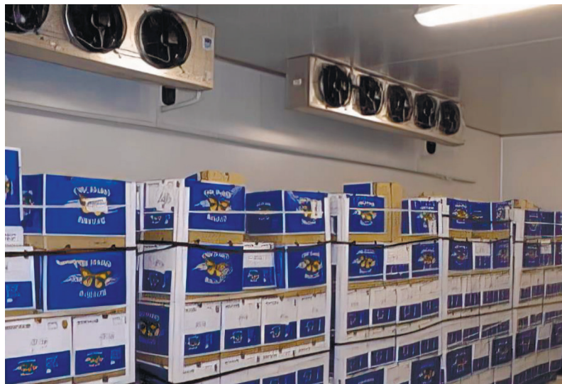
Рис. 5.32. Система охолодження камери з РГС
