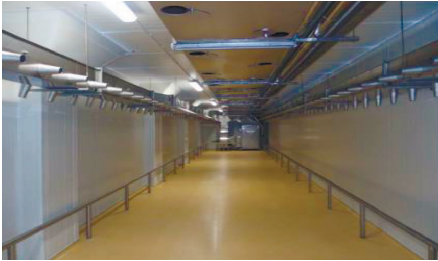
Рис. 2.15. Камера охолодження м'яса з системою повітряного душування з двоступінчастою подачею
