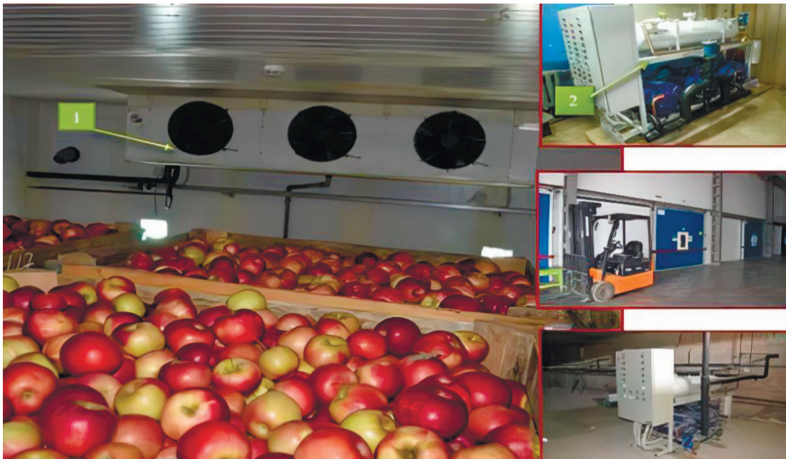
Рис. 2.36. Камера охолодження фруктів із інтенсивним рухом повітря: 1 – компресорно-конденсаторний агрегат; 2 – стелевий повітроохолоджувач із повітроводом
