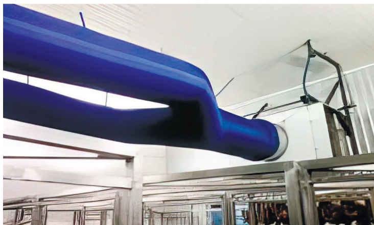
Рис. 1.14. Система кондиціювання повітря камери готової продукції м'ясопереробного заводу
