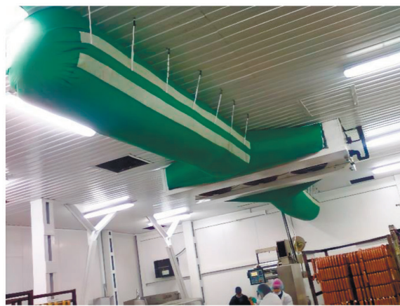
Рис. 1.15. Застосування текстильних повітропроводів круглого перетину в холодильній камері (а) та в ковбасному цеху (б)
