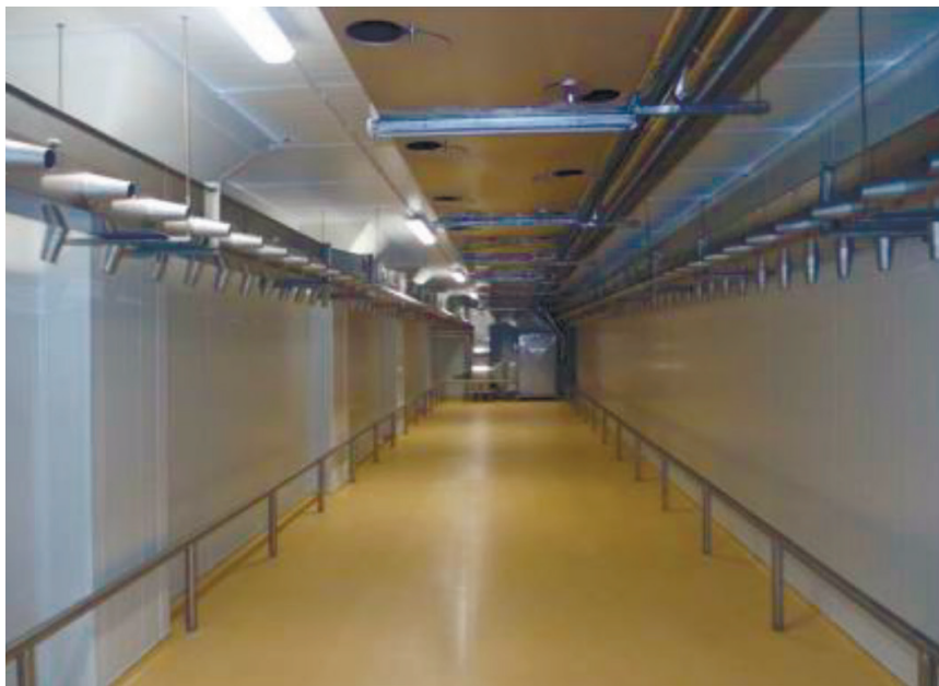
Рис. 2.14. Камера охолодження м'яса з системою повітряного душування
