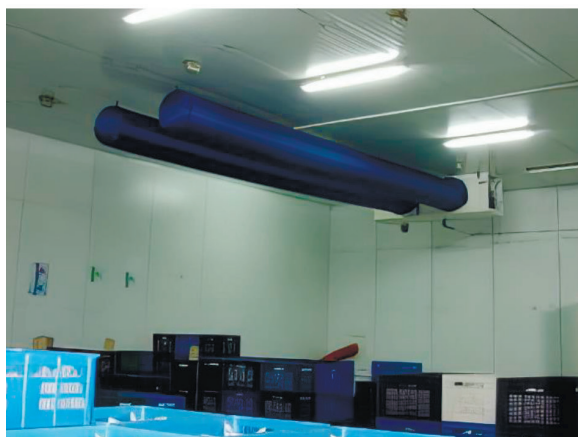
Рис. 1.15. Застосування текстильних повітропроводів круглого перетину в холодильній камері (а) та в ковбасному цеху (б)
