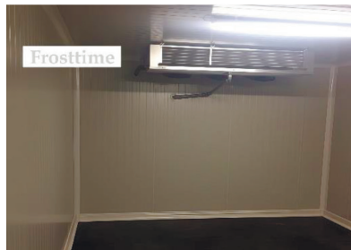
Рис. 2.1. Приклад камери охолодження м'яса
