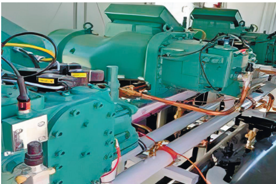
Рис. 5.21. Холодильне устаткування в камерах з РГС
