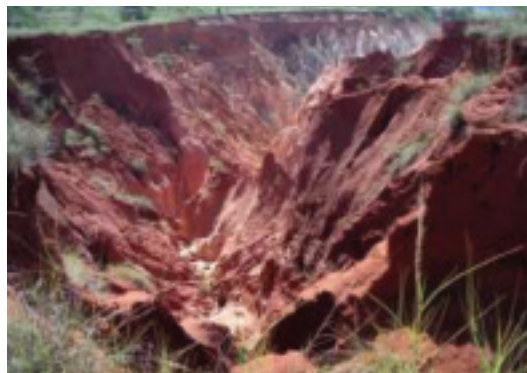
Рис. 43. Наслідки розмивання ґрунту
