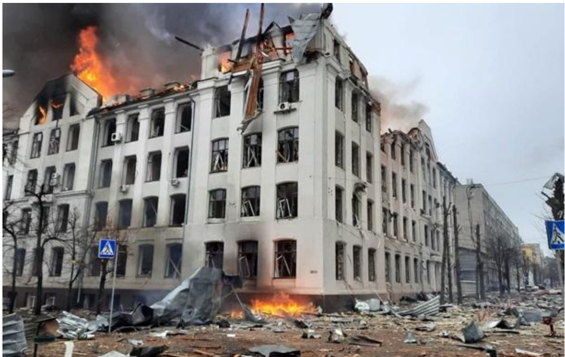
Рис. Б.2. Фото зруйнованого внаслідок ракетних ударів будівлі корпусу Харківського національного університету імені В.Н. Каразіна (м. Харків)
