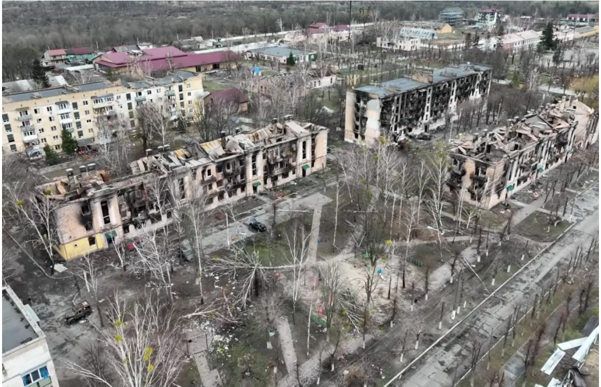
Рис. Б.9. Зруйноване війною м. Гостомель, Київська обл.
