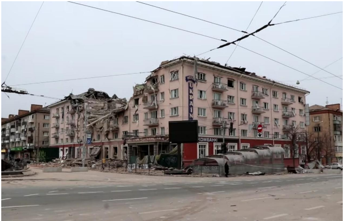
Рис. Б.8. Зруйнована війною будівля готелю «Україна», м. Чернігів
