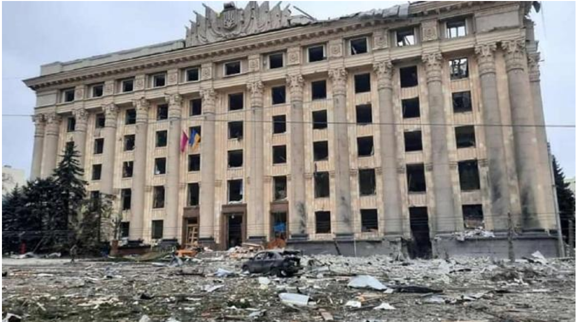
Рис. Б.1. Фото зруйнованої внаслідок ракетних ударів будівлі Харківської обласної державної адміністрації (м. Харків)
