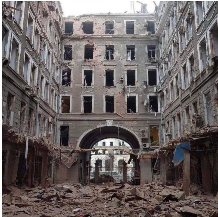
Рис. Б.4. Фото зруйнованої будівлі «Палацу праці», м. Харків, пам'ятка архітектури
