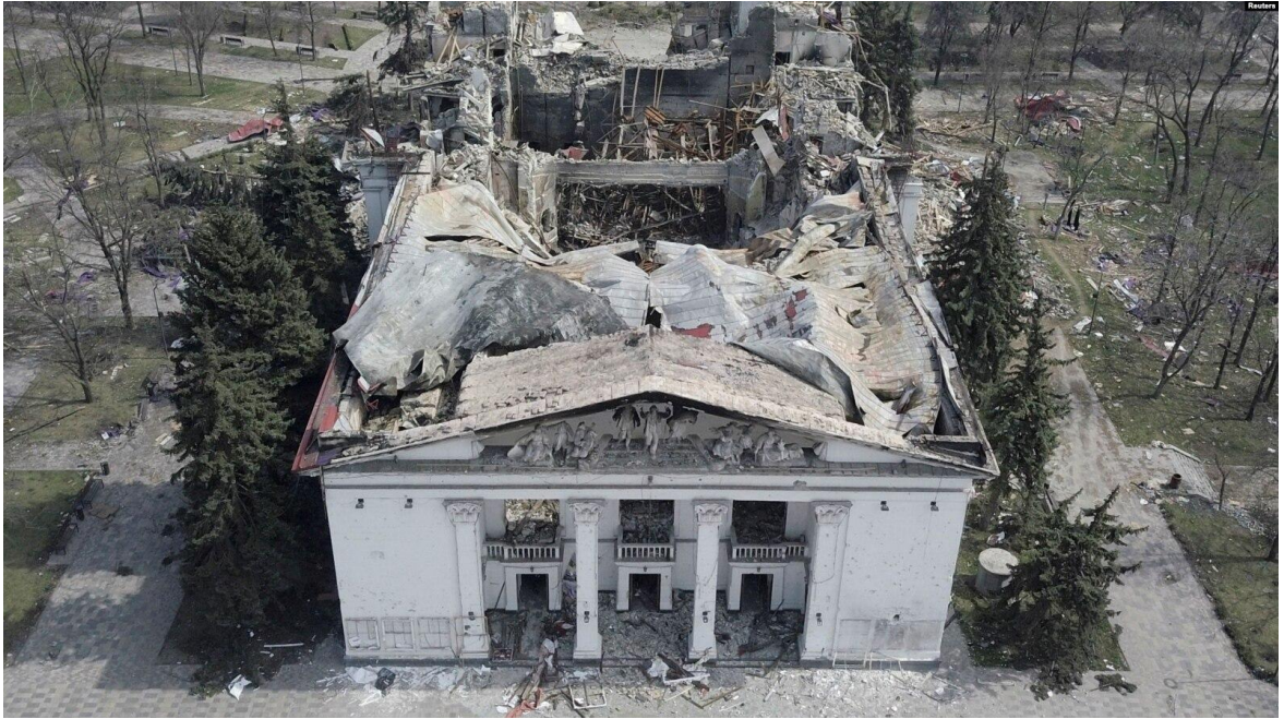
Рис. Б.7. Зруйнована війною будівля Донецького обласного драматичного театру, м. Маріуполь
