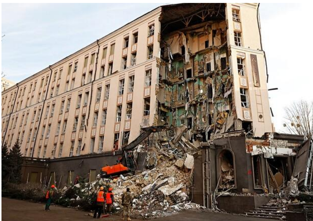
Рис. Б.6. Пошкоджена ракетним ударом у 2022 р. будівля готелю "Alfavito", м. Київ
