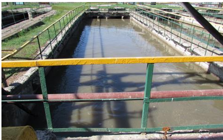
Рисунок 3.24 – Горизонтальний відстійник
