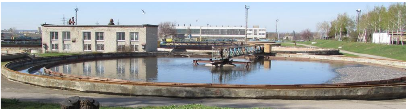
Рисунок 3.26 – Радіальний відстійник: а – схема; б – загальний вигляд
