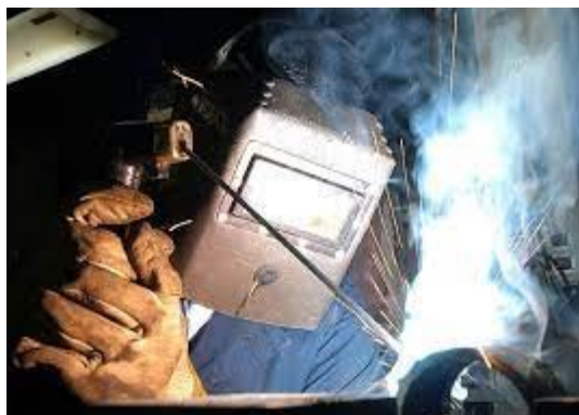
Рис. 9.1. Електродугове зварювання металів
