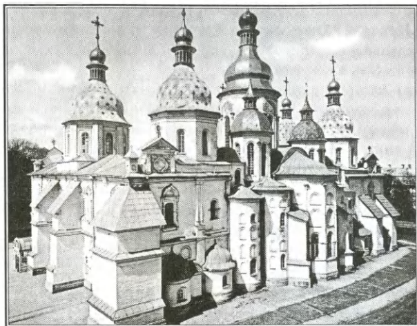
Рис. 55. Загальний вигляд Софійського собору з південно-східного боку. Фото початку XX ст.
