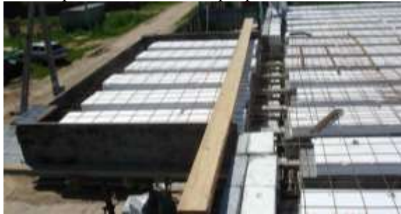
Рис. 5.4.4. Приклеювання пінополістирольних плит для збільшення несучої здатності перекриття
