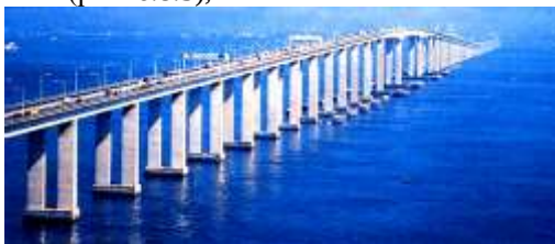
Рис. 6.8.5 – Балкові мости: а – «Rio Niteroi» Бразилія; б – «Kwang Ahn» (Пусан, Корея)
