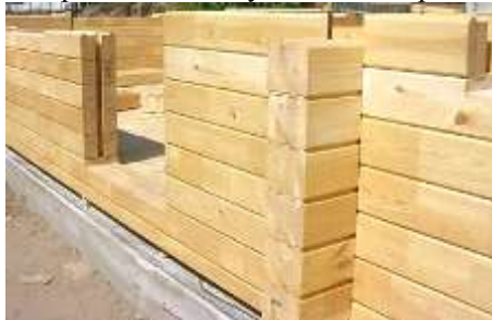
Рис.5.7.5. Стіни зруба з клеєного бруса
