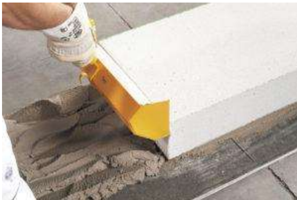
Рис. 5.3.2. Вкладання першого ряду блоків
