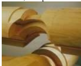
Рис.5.7.4. Вид замків колод для зруба
