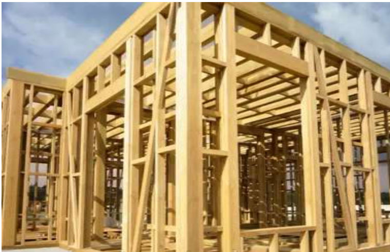
Рис.5.7.14. Встановлення стійок і розкосів
