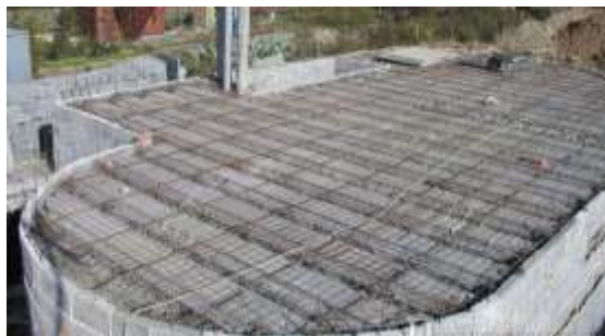
Рис. 5.4.5. Влаштування криволінійного перекриття
