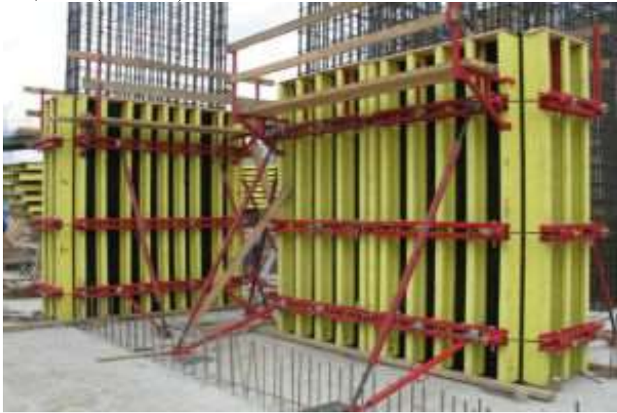
Рис. 5.1.7. Розбірно-пересувна опалубка
