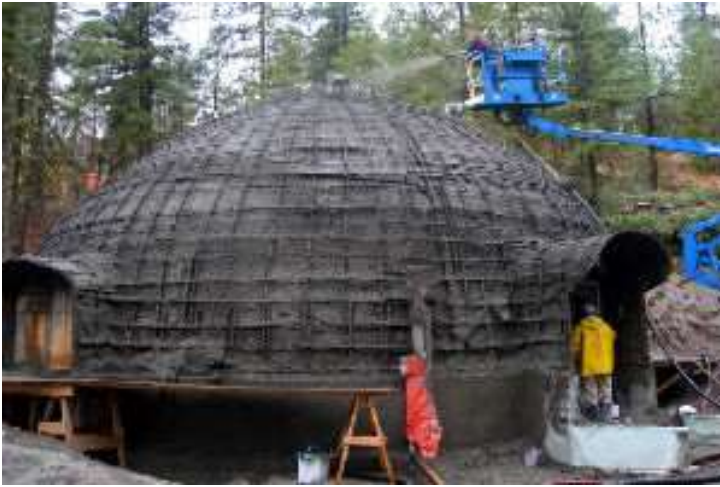
Рис. 5.1.4. Надувна опалубка
