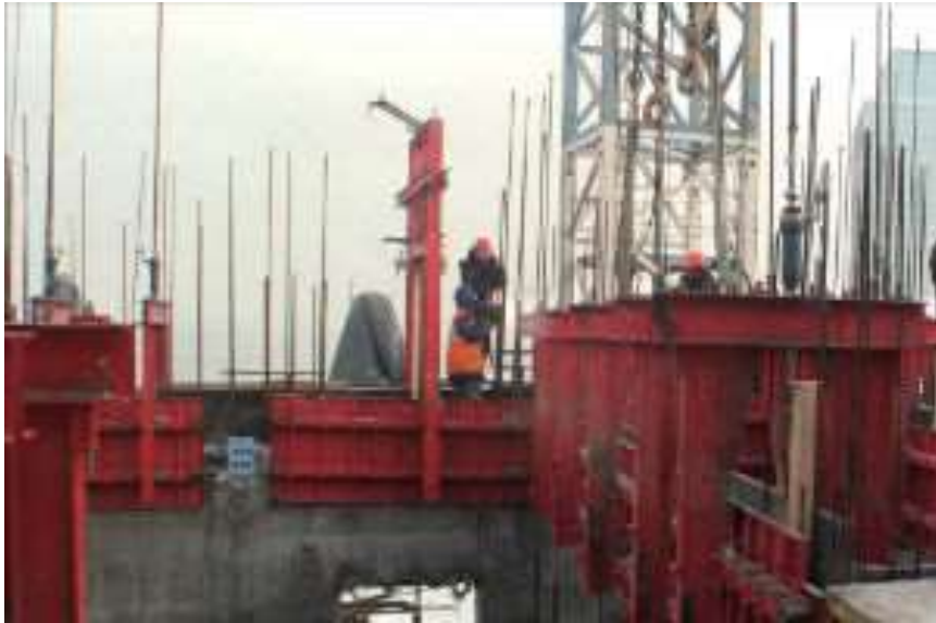
Рис. 5.1.8. Опалубка, що ковзає
