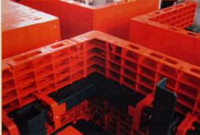
Рис. 5.1.5. Пластмасова опалубка
