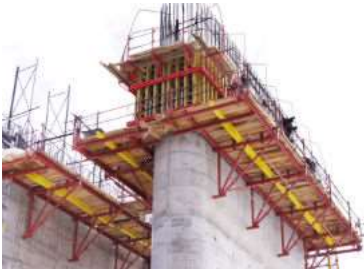
Рис. 5.1.6. Підйомно-пересувна опалубка
