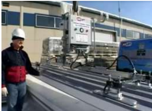
Рис.5.5.8. Застосування траверси з вакуумними присосками для підняття сендвіч-панелей
