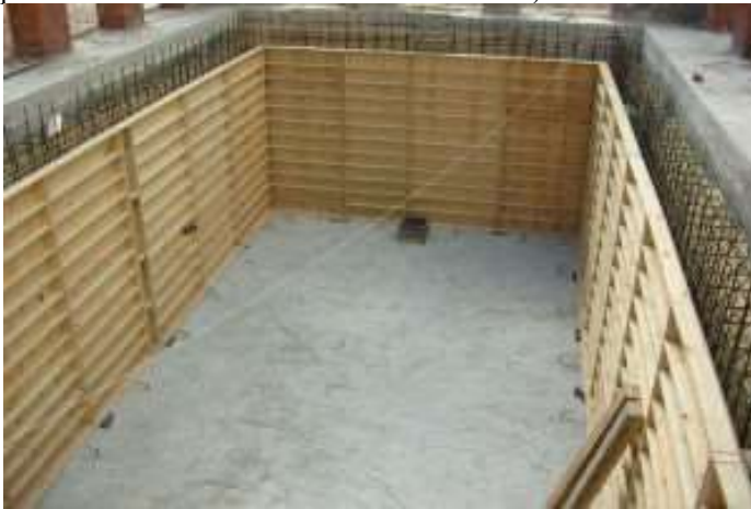
Рис. 5.1.2. Дерев'яна опалубка
