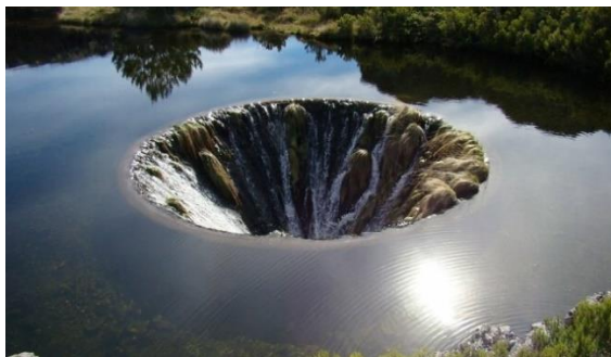
Рис. 7.7. Кончос - водосховище з вертикальним приймальним резервуаром діаметром 48 м для відведення води (Португалія)
