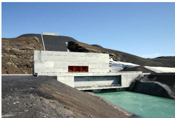
Рис. 7.2. ГЕС Ватнсфелл працює на гідроресурсах водосховища Торісватн (Ісландія)
