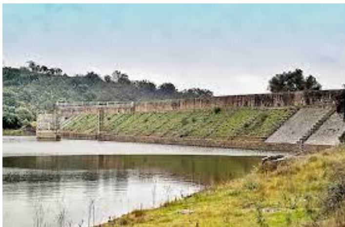
Рис. 7.2. Корналво - земляна гребля, з кам'яним облицюванням в басейні р. Гвадіана, споруджена римлянами у I-II ст. н.е., діє в наш час (Іспанія)
