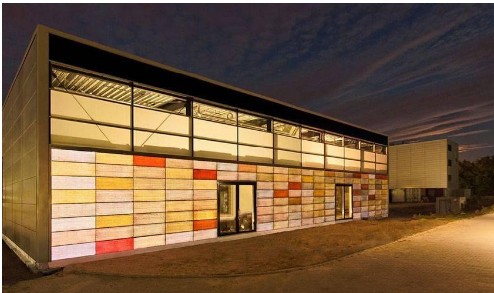
Рис. 6. Застосування склобетону при оформленні фасаду.
