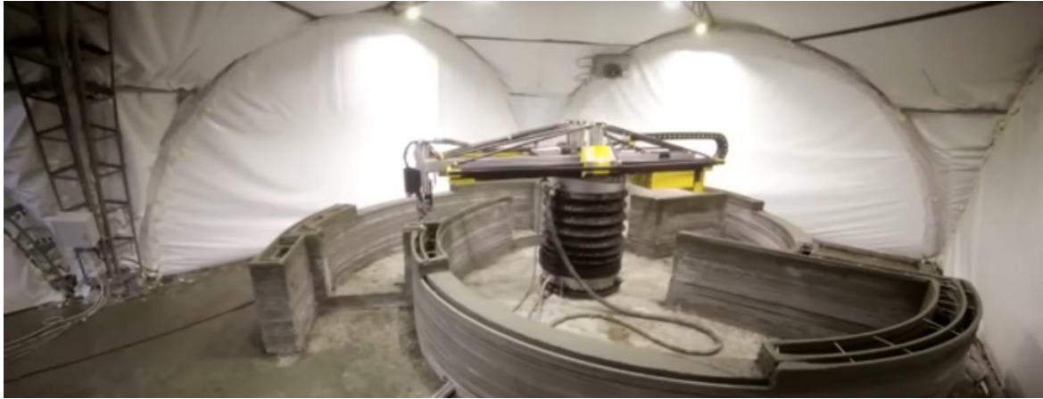
Рис. 6. Фотофрагмент роботи на будівництві
