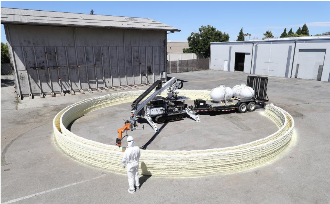
Рис. 4. Фотофрагмент опалубочні роботи з піни
