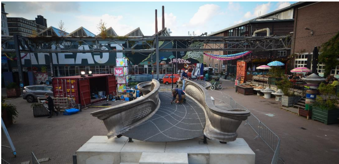
Рис. 3. Фотофрагмент конструкції пішохідного моста
