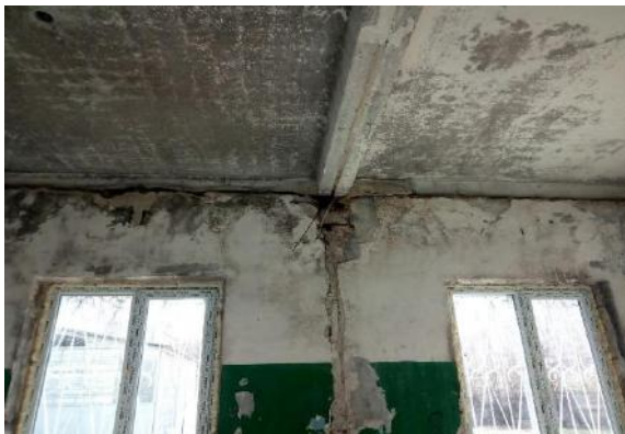
Рисунок 2 - Технічний стан примикання плит перекриття до зовнішніх стін та підлоги
