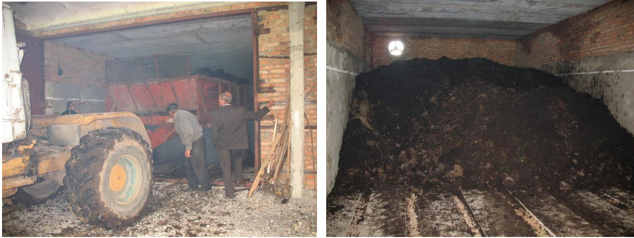
Рис. 2 - Фото процесу завантаження ферментатора
