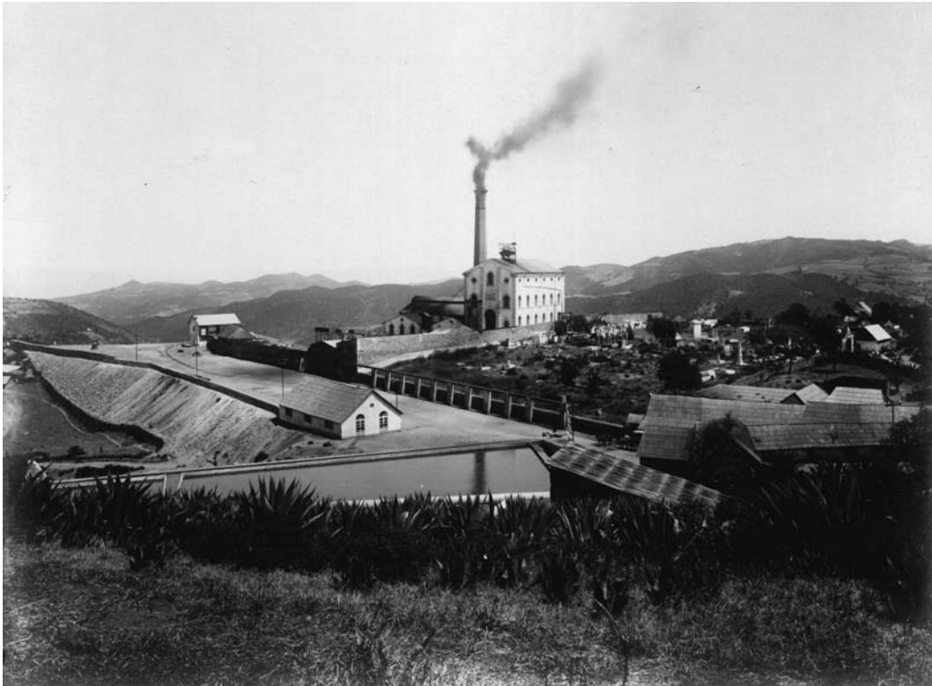
Figure 8.1 “La Dificultad” mine, Real del Monte, Hidalgo
