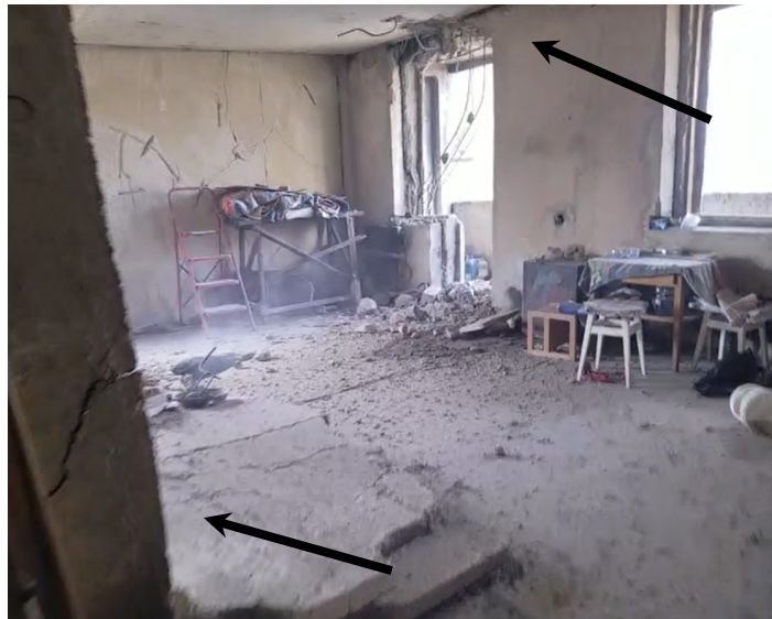
Рис. 2. Загальний вигляд цієї ж квартири після другого влучання 122 мм реактивного снаряду, який пробив міжповерхові плити (стрілками позначені вхідний (на стелі) та вихідний (на підлозі) отвори пошкоджень)
