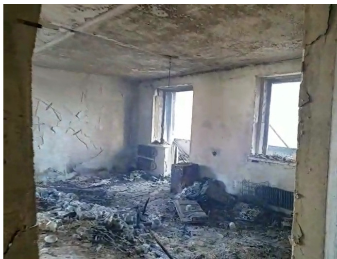
Рис. 1. Загальний вигляд квартири після першого влучання 122 мм реактивного снаряду через вікно
