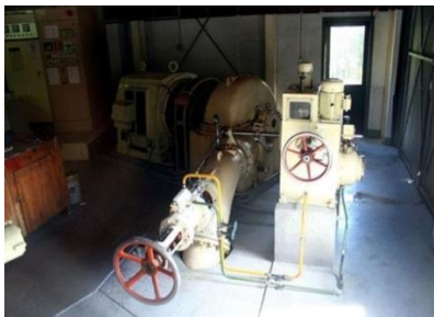
Рис. 4.11. Вигляд турбіни Турго
