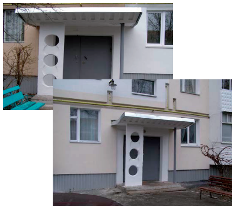
Рис. 6.8, 6.9. Заміна вікон під'їздів та вхідних дверей.
