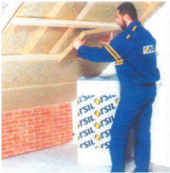
Рис. 4.3. Утеплення приміщення на горищі.
