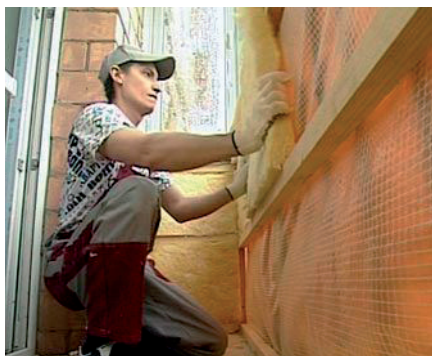
Рис. 4.15. Утеплення фасаду мінераловатними плитами.
