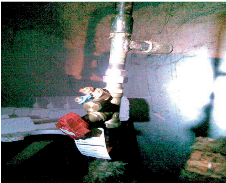
Рис. 6.11. Встановлення балансувальних клапанів на стояки системи опалення.
