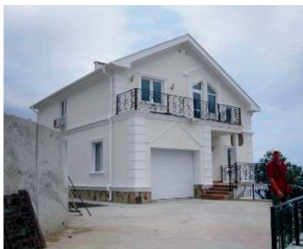
Рис. 4.16. Приклад утеплення фасаду штукатуркою тепловер.
