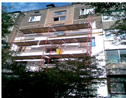
Рис. 6.7. Утеплення стін
