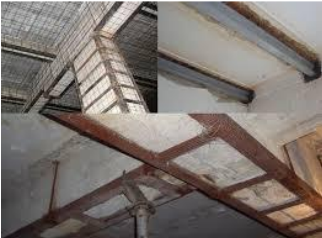
Рис.4.1. Загальний вигляд підсилення ригеля
