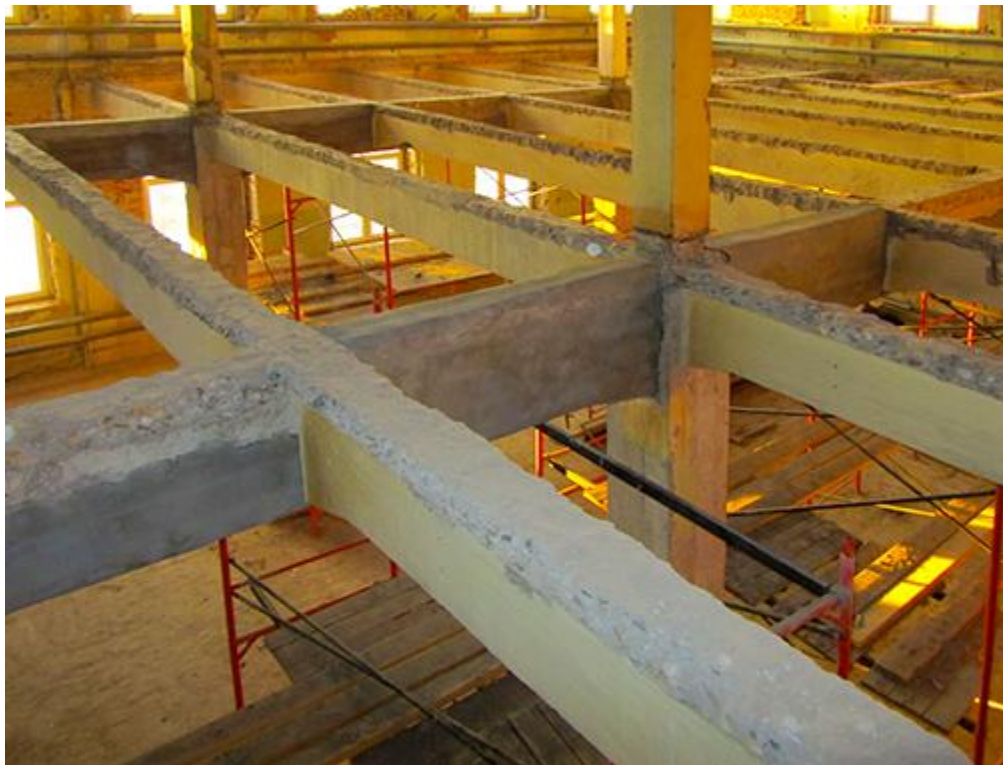
Рис. 2.1. Загальний вигляд каркаса будівлі
