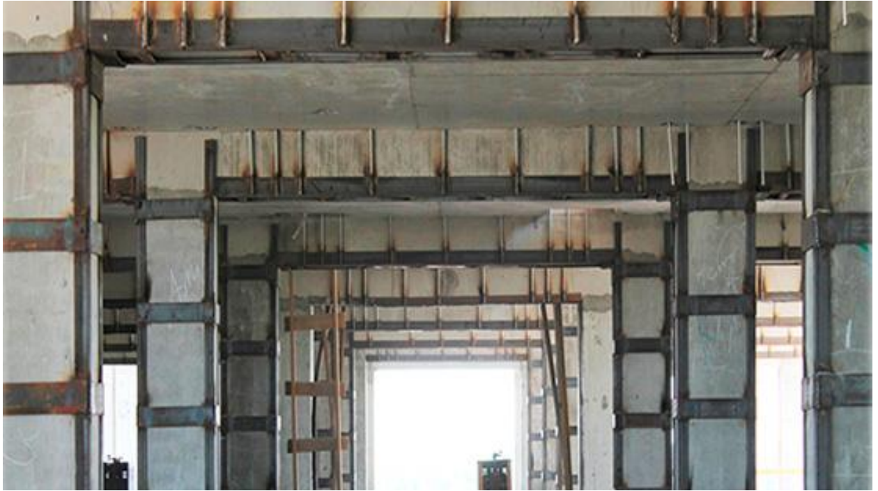
Рис. 2.2. Підсилення залізобетонних конструкцій
