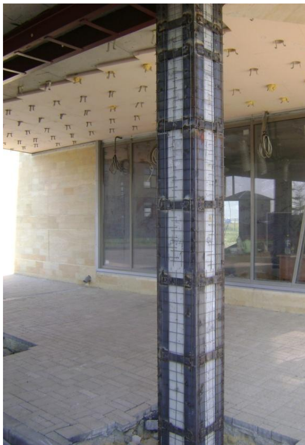
Рис. 3.1. Загальний вигляд металевої обойми
