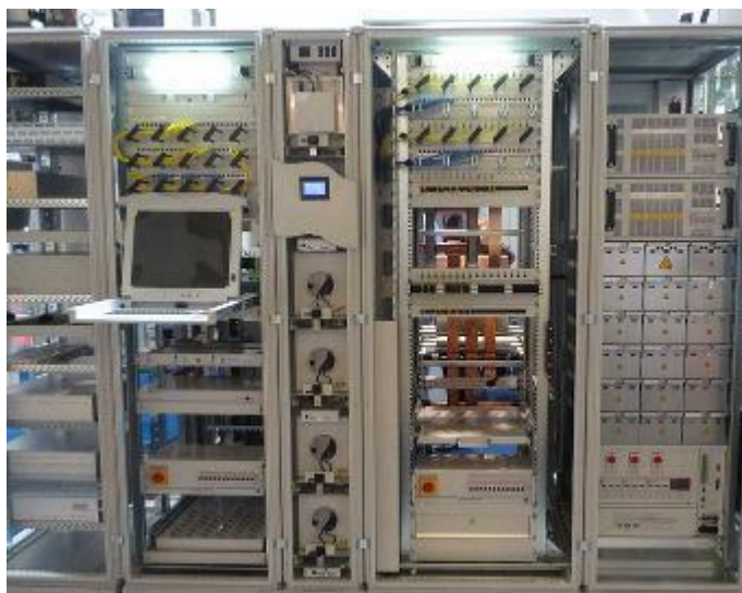
Рисунок 5.2 – Технологічні шафи диспетчерського пункту SCADA-системи
