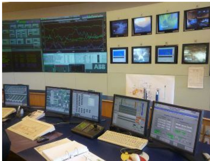
Рисунок 5.3 – Диспетчерський пульт із SCADA-системою
