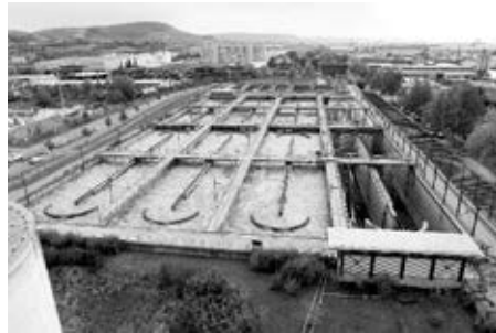
Аеротенк під час роботи/ під час виконання ремонтних робіт
