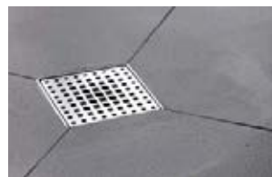
Мал. 16 - Трапи за будовою: а) – дренажний канал; б) – трап
