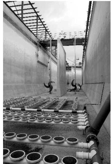
Мішалки та система аерації
