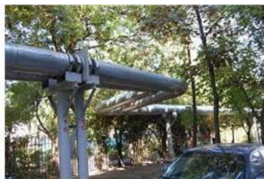
Рисунок 1.5.2.3 – Прокладка теплових мереж на опорах
