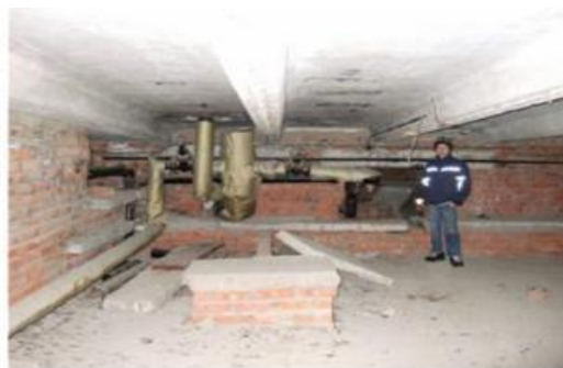
Рисунок 1.1.4.1 – Ведення водопроводу через стіну підвалу у сухих ґрунтах
