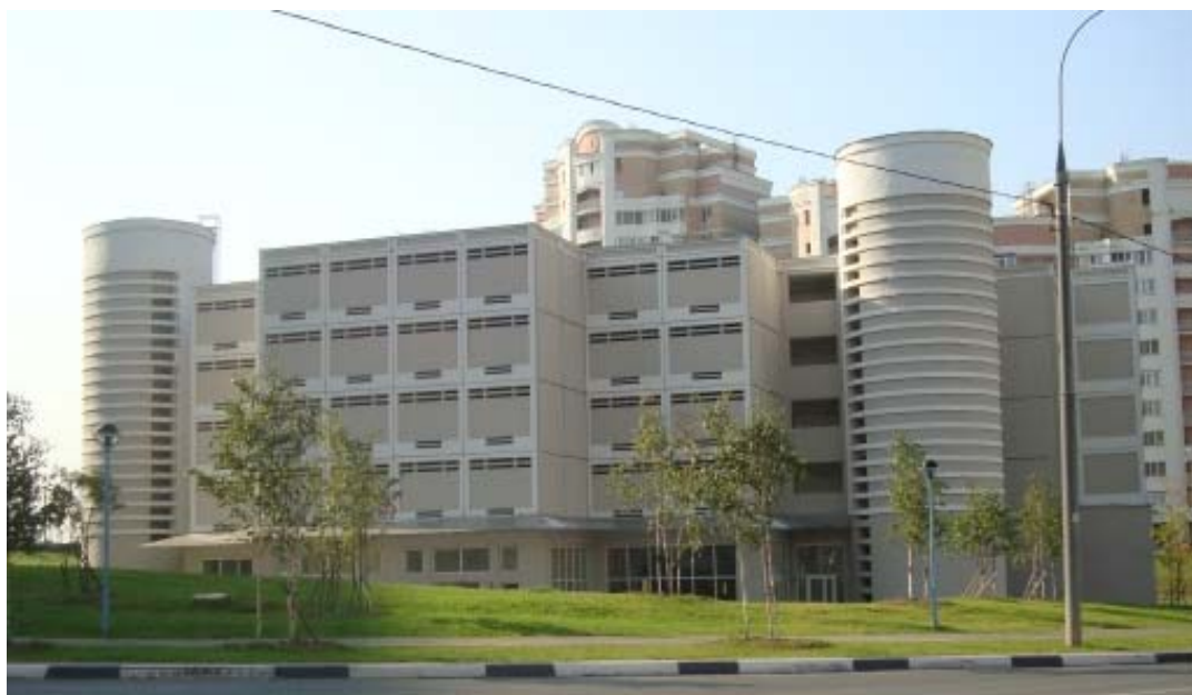
Рисунок 14.11 – Багаторусний паркінг. Поверховість: 4 наземних, 2 підземних, боксове зберігання, 454 машиномісць, площа забудови – 0,26 га.
