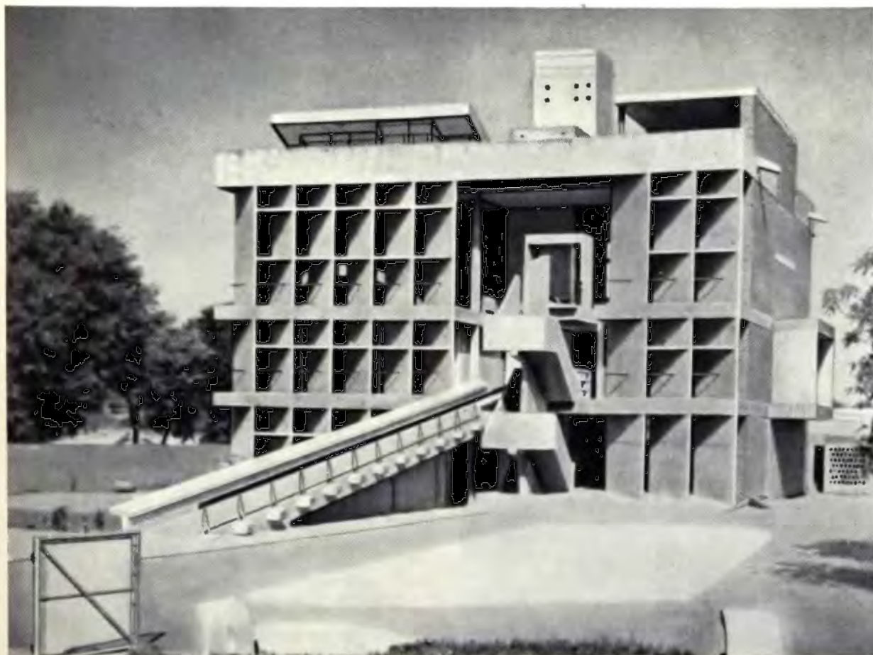
Дом Текстильной ассоциации в Ахмедабаде, 1954—1957. Западный фасад.
