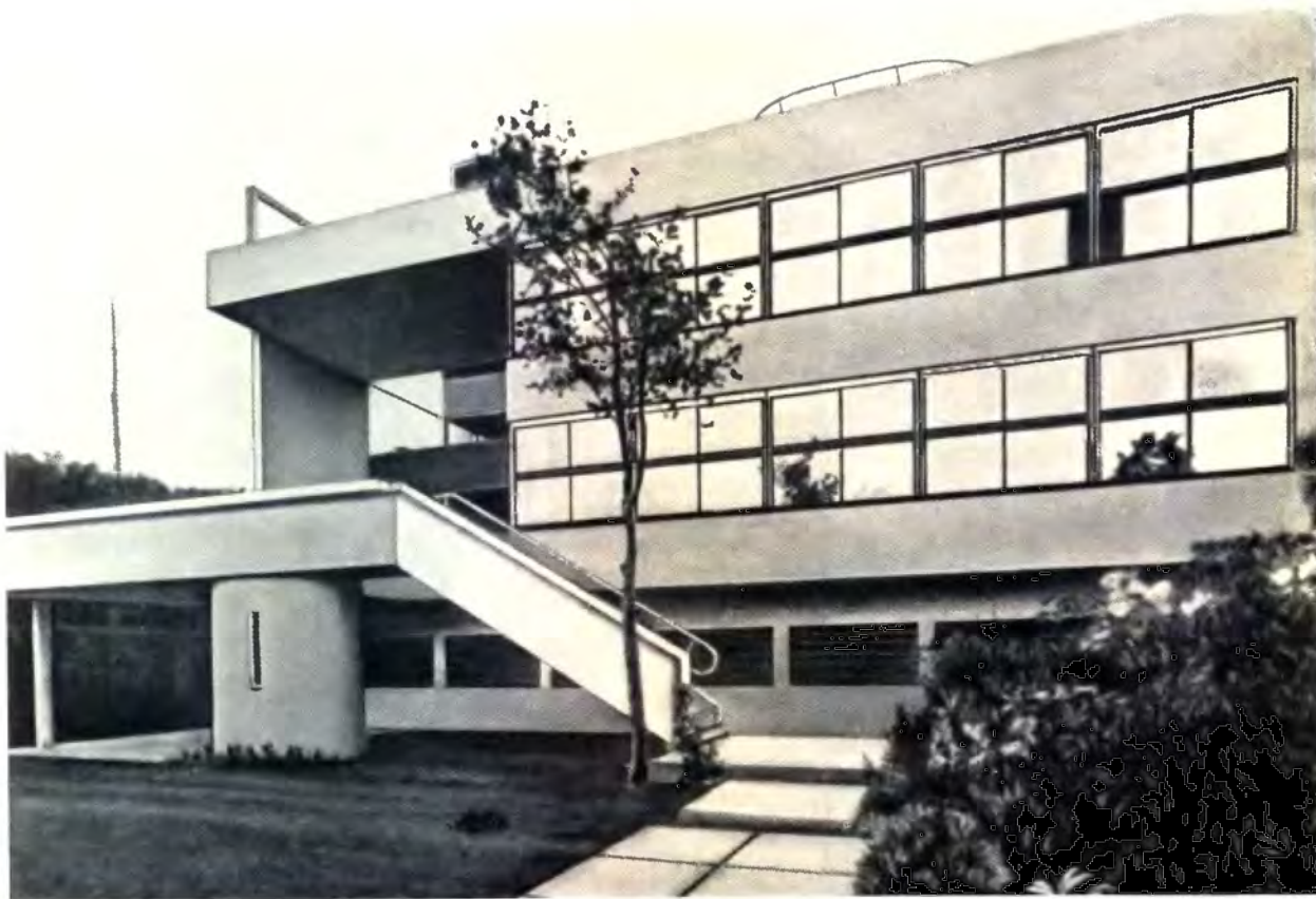
Вилла в Гарше под Парижем. Фрагмент южного фасада.
