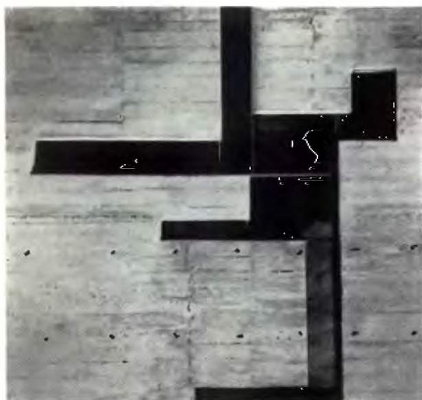
Доминиканский монастырь в Ла-Туретте, близ Лиона. 282 Железобетонная стена лестничной клетки.
