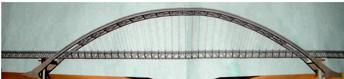
Рис. 3 Общий вид мостового перехода.
