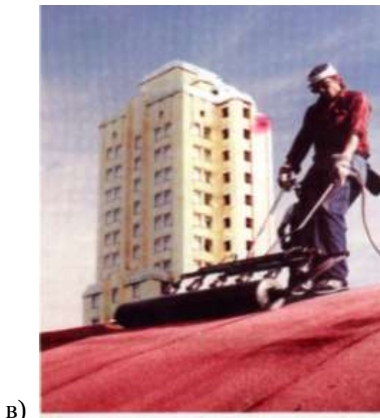
Рис. 6.68 – Укладання верхнього гідроізолюючого рулонного матеріалу із використанням зварювального апарату: а – б – із одним пальником; в – шістьма пальниками; г – зварюванням шва одним пальником та механічним кріпленням
