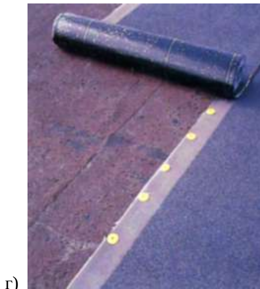
Рис. 6.68 – Укладання верхнього гідроізолюючого рулонного матеріалу із використанням зварювального апарату: а – б – із одним пальником; в – шістьма пальниками; г – зварюванням шва одним пальником та механічним кріпленням
