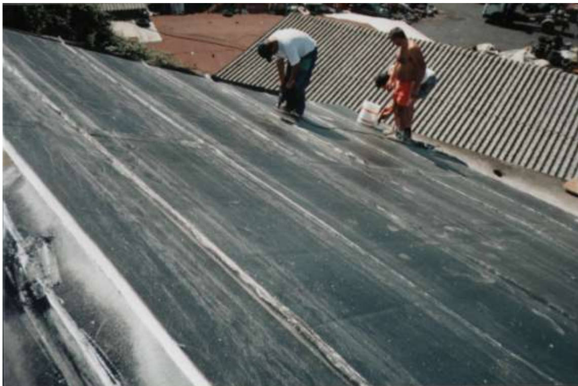
Рис. 6.63 - Улаштування утеплюючого шару із плит, що мають один шар гідроізоляції
