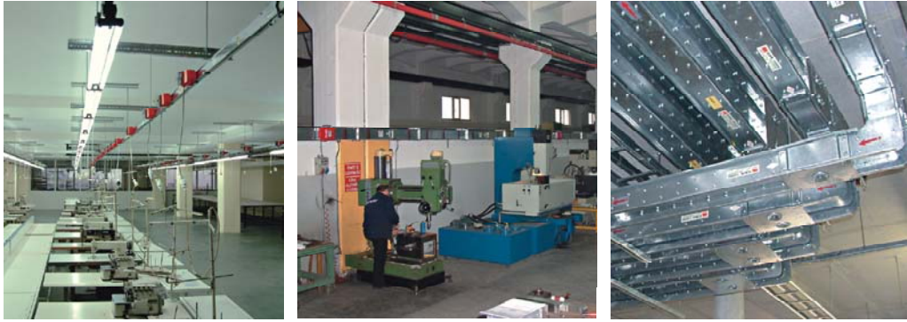
Рис. 4.140. Приклади застосування систем збірних розподільних шинопроводів
