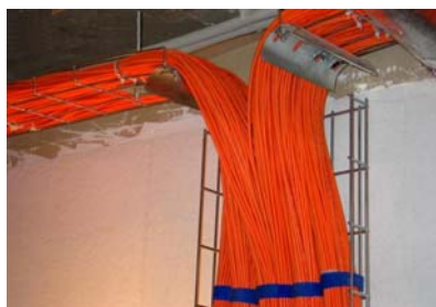
Рис. 4.159. Кутові прокладки, змонтовані на решітчастих кабельних лотках
