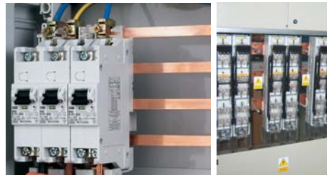
Рис. 4.139. Збірні шини як засіб монтування комутаційних апаратів
