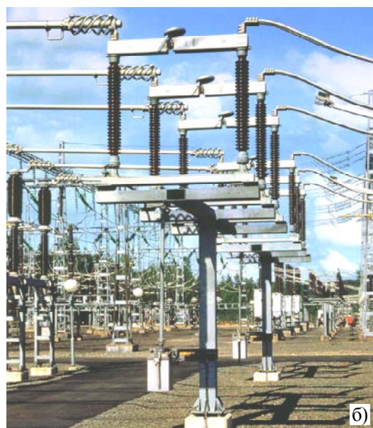
Рис. 4.110. Роз'єднувачі з центральним розми-канням: а – роз'єднувач для мереж з номінальною напругою 220 кВ; б – роз'єднувач для мереж з номінальною напругою до 420 кВ
