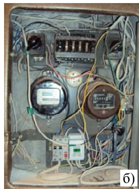
Рис. 4.114. Електрична схема розподільного щитка, розрахованого на дві квартири, в житлових будинках 70-х – 80-х років (а) та його загальний вигляд (б). В лівій частині щитка, що живить одну з квартир, апарати не замінювалися; в правій частині щитка комутаційні апарати були замінені на сучасні, встановлений захист від підвищення напруги мережі, але апарати захисту людей від прямих та непрямих дотиків не встановлені
