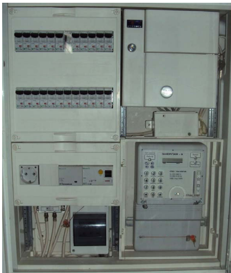
Рис. 4. 115. Рекомендована електрична схема розподільного щитка сучасної квартири середньої комфортності (а) та фото розподільного щитка сучасної квартири підвищеної комфортності (б)
