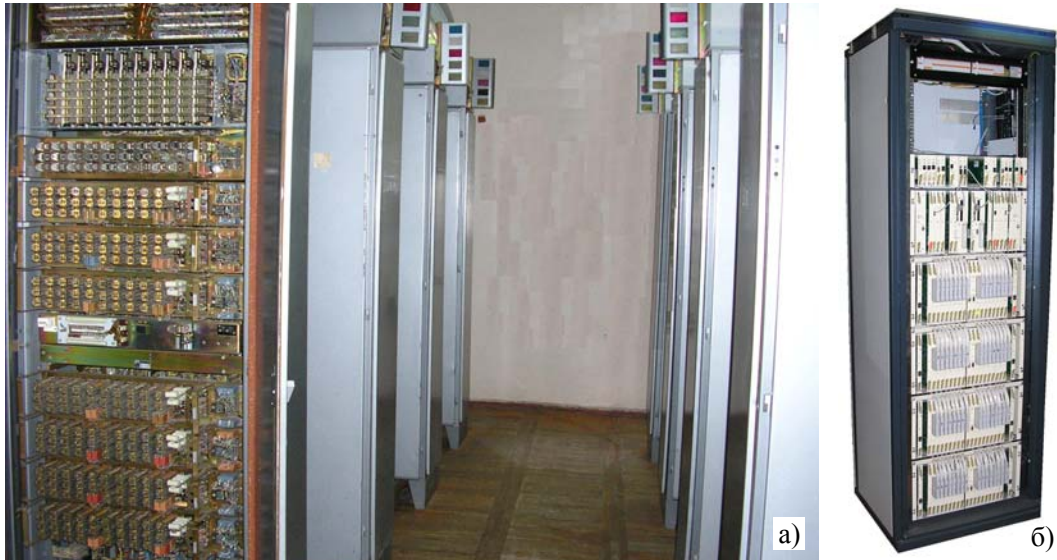
Рис. 1.69. Електромеханічна (а) та цифрова (б) АТС
