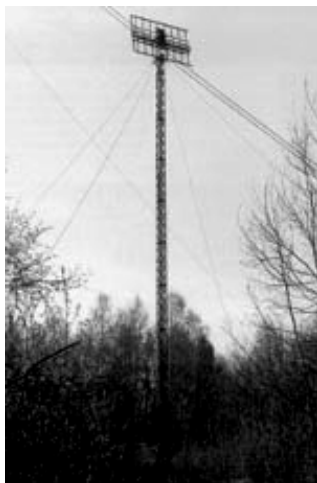
Рис. 4. Мачта (высота 30...50 м) с антенной бистатической РЛС «Струна» (ОАО НИТЕЛ, РФ)
