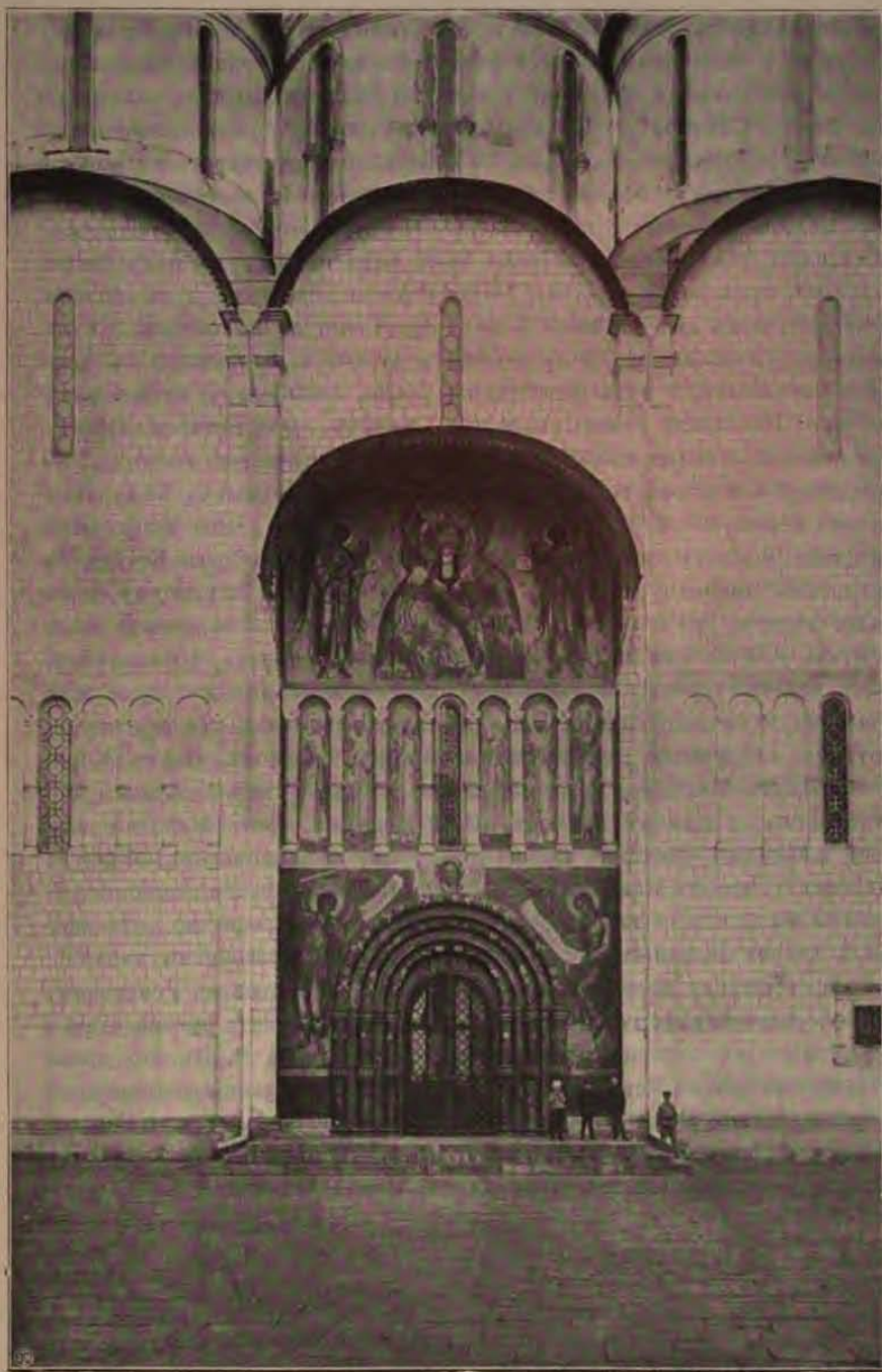
Рис. 7. Наружная стѣнопись надъ южными входными дверями.
